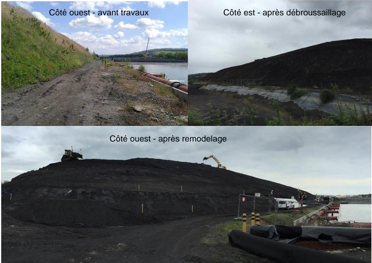
Figure 1. Photographies du stock de boues dans son état initial, suite au débroussaillage et après remodelage.
