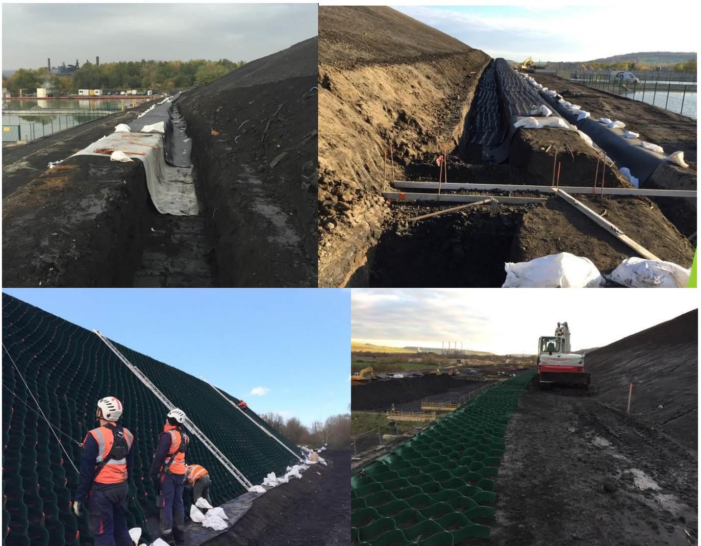
Figure 5. Mise en œuvre des géosynthétiques de la couverture équivalente du talus 1H/1V.
