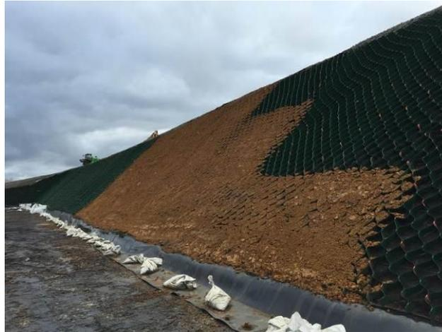
Figure 7. Planche d'essais du géocomposite alvéolaire – décembre 2015.
