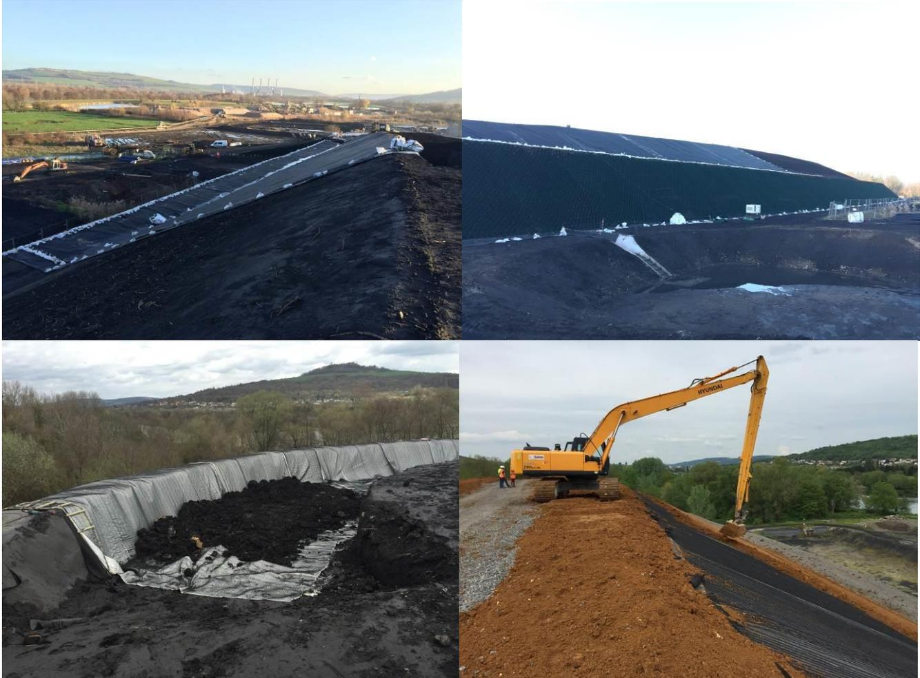
Figure 6. Mise en œuvre des géosynthétiques et de la terre végétale de la couverture équivalente du talus 2H/1V.
